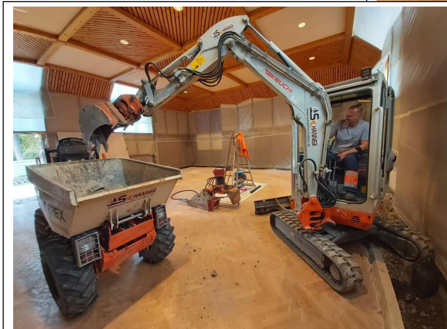
Bauhofleiter Rene Koch beim ausbaggern des Grabens.
