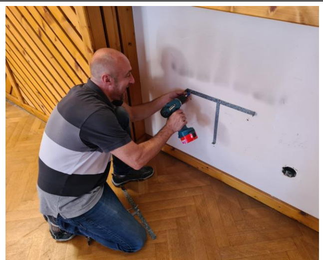
Hansi bei der Demontage der Heizkörperhalterung.
